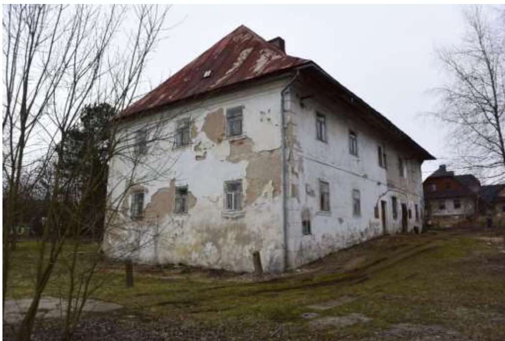
Obr. 17. Cikháj, místní část Dvůr. Západní, obytné křídlo čtyřstranného panského dvora z pohledu od jihovýchodu. Foto autor, 2018.
