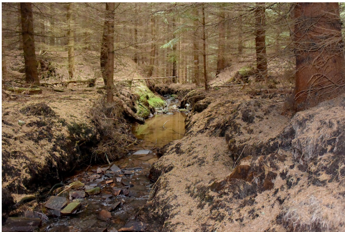
Obr. 19. Holcovský potok protékající protrženou hrází zaniklé vodní nádrže. Pohled z návodní strany. Foto Pavel Rous 2017.
