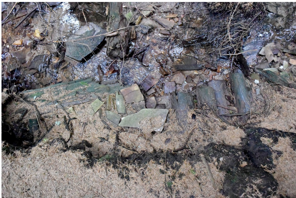
Obr. 24. Bližší pohled na lépe dochovanou, pravobřežní část porušené dřevěné konstrukce vybíhající z pravého břehu Holcovského potoka. Foto Pavel Rous 2017.
