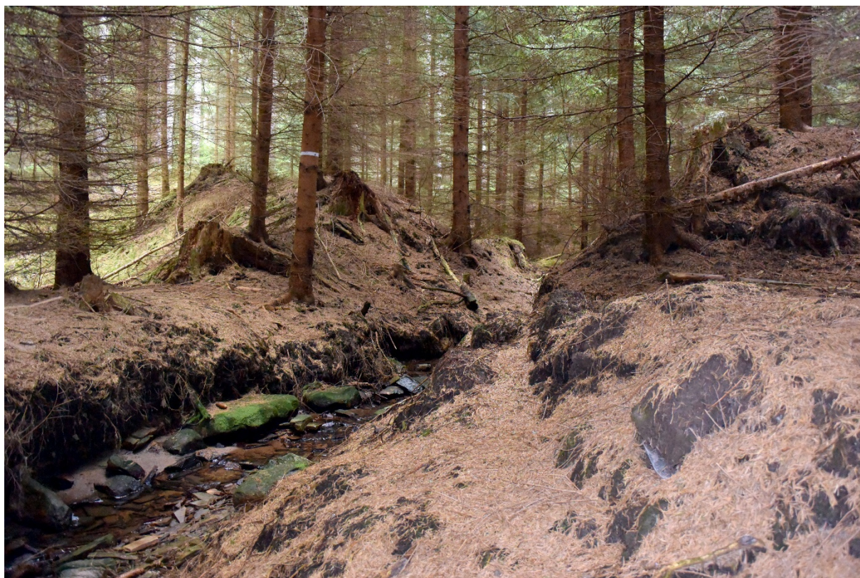
Obr. 20. Vnější strana hráze v místě průtoku Holcovského potoka. Foto Pavel Rous 2017.
