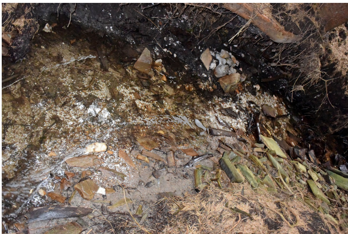
Obr. 22. Křemenná drť vyplavená z pravého břehu Holcovského potoka v úseku pod hrází zaniklé vodní nádrže. Foto Pavel Rous 2017.
