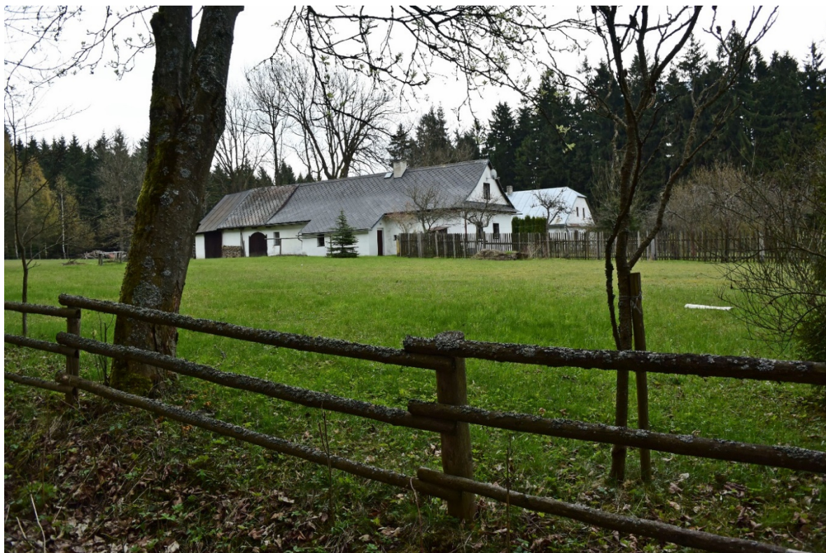
Obr. 7. Nová Huť, stavení čp. 9. a 8. stojící na místě hutní haly Vojnoměstské sklárny. Pohled od západu. Foto Pavel Rous 2017.
