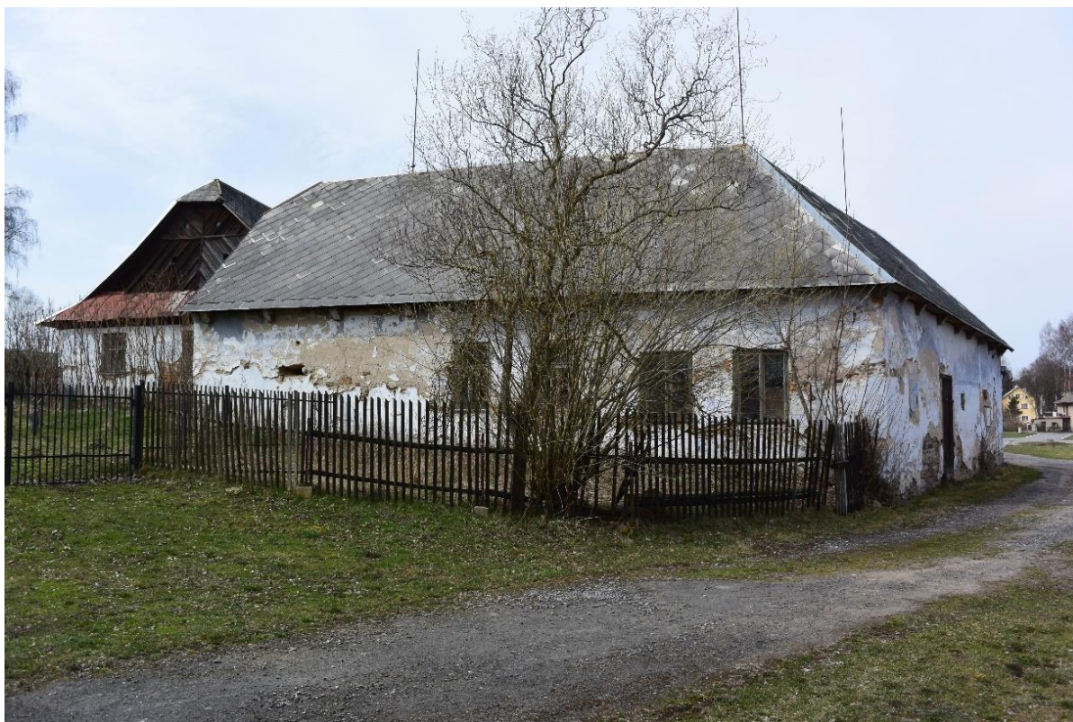
Obr. 8. Usedlost čp. 82 z pohledu od jihovýchodu. Foto P. Rous, 2016.
