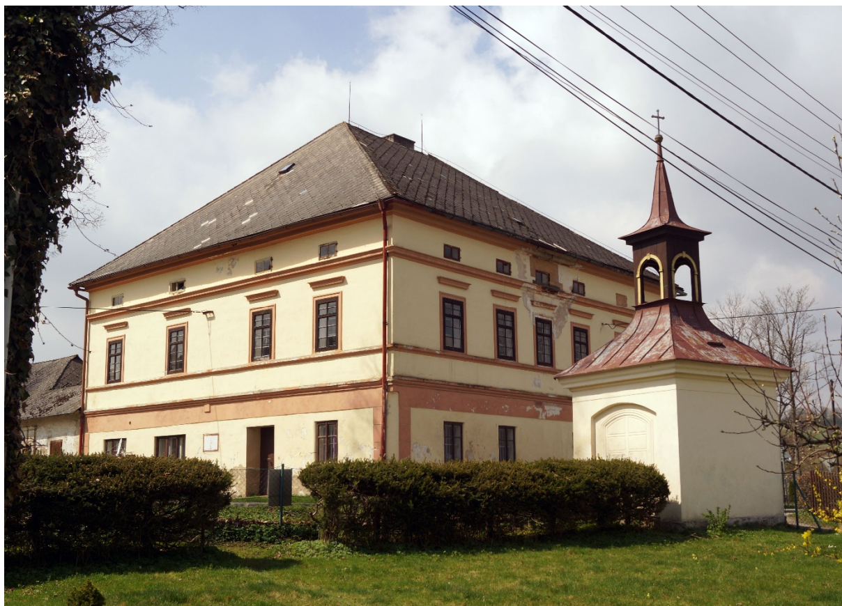
Obr. 17. Panský dům z pohledu od čp. 20. V popředí kaplička P. Marie Pomocnice. Foto Radim Gonda 2018.
